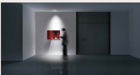
Brandbekämpfungs- und Sicherheitseinrichtungen: 5 lx vertikal beleuchten
